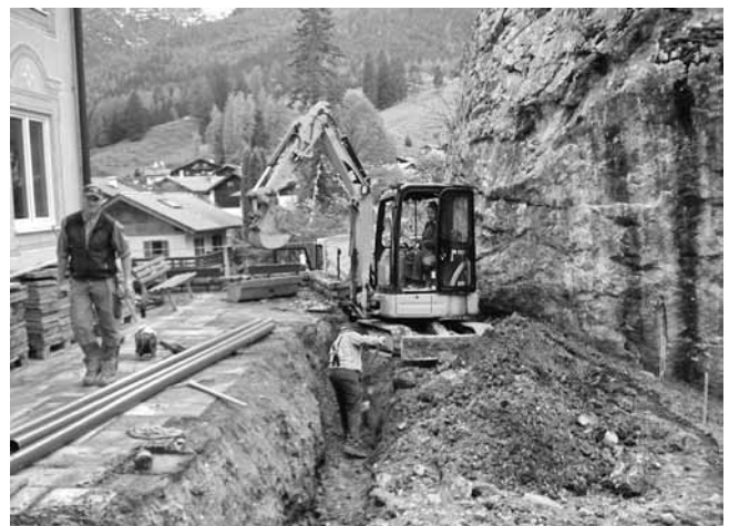
Die Rohre für die Steuerleitungen der Wasserversorgung werden ins Rathaus verlegt.
