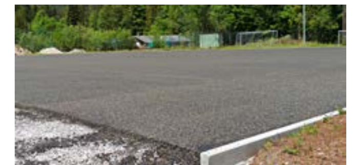
Der neue Kunstrasenplatz während der Bauphase
