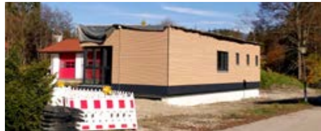
Das Modulhaus der Aufbauphase
