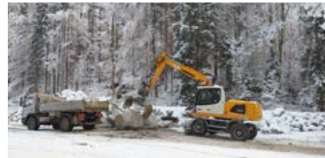
Bauzwischenlager an der Alpspitzstraße Foto: ER
