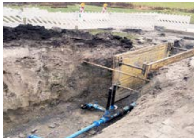
Loisachstraße während der Neuverlegung der Wasserleitung Foto: RED
