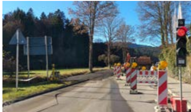
Eibseestraße während der Neuverlegung der Wasserleitung Foto: ER
