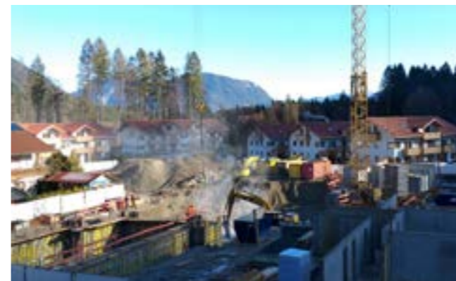
Bauarbeiten in der Siedlung Foto: ER
