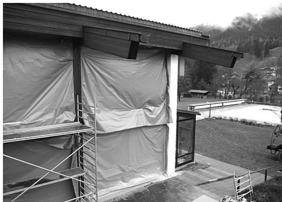
Energetische Sanierung des Kurhauses Einbau der neuen Fensterscheiben
