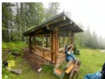
Nur noch das Außengerüst der Hütte steht
