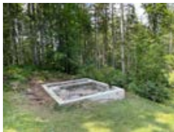
Das Fundament steht noch und wird entfernt
