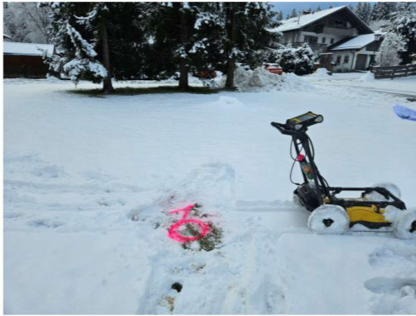
Messung des Bohransatzpunktes 1
