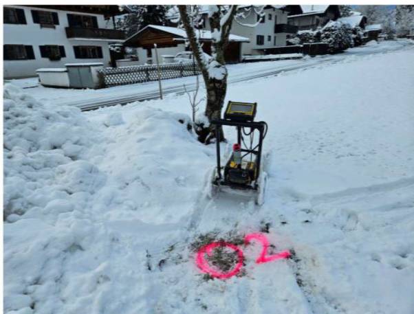
Messung des Bohransatzpunktes 5
