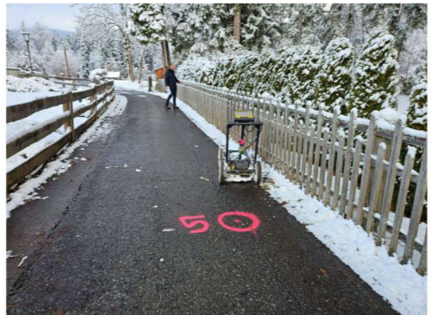
Messung des Bohransatzpunktes 10
