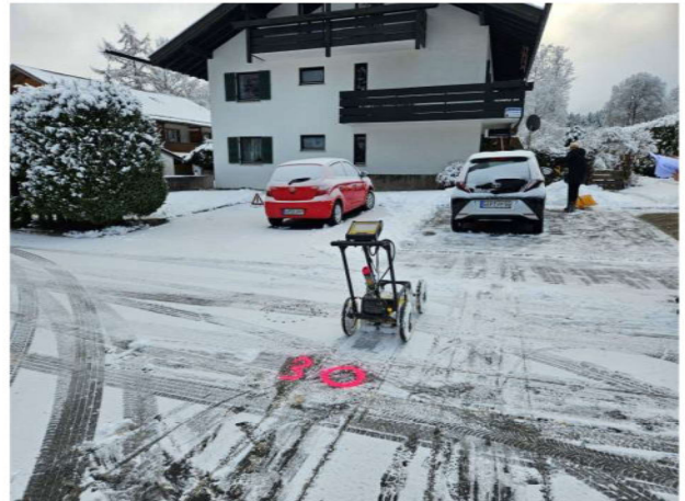
Messung des Bohransatzpunktes 2
