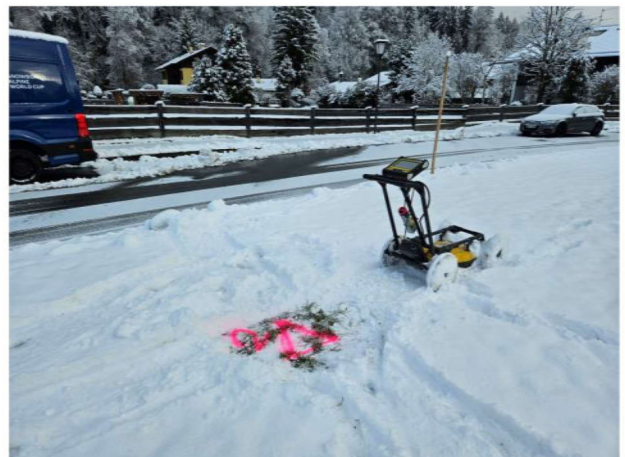
Messung des Bohransatzpunktes 4
