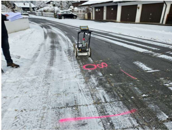
Messung des Bohransatzpunktes 7
