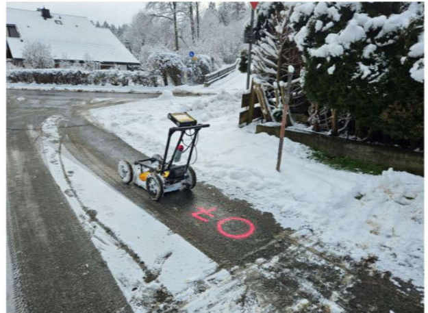
Messung des Bohransatzpunktes 8
