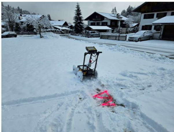
Messung des Bohransatzpunktes 3
